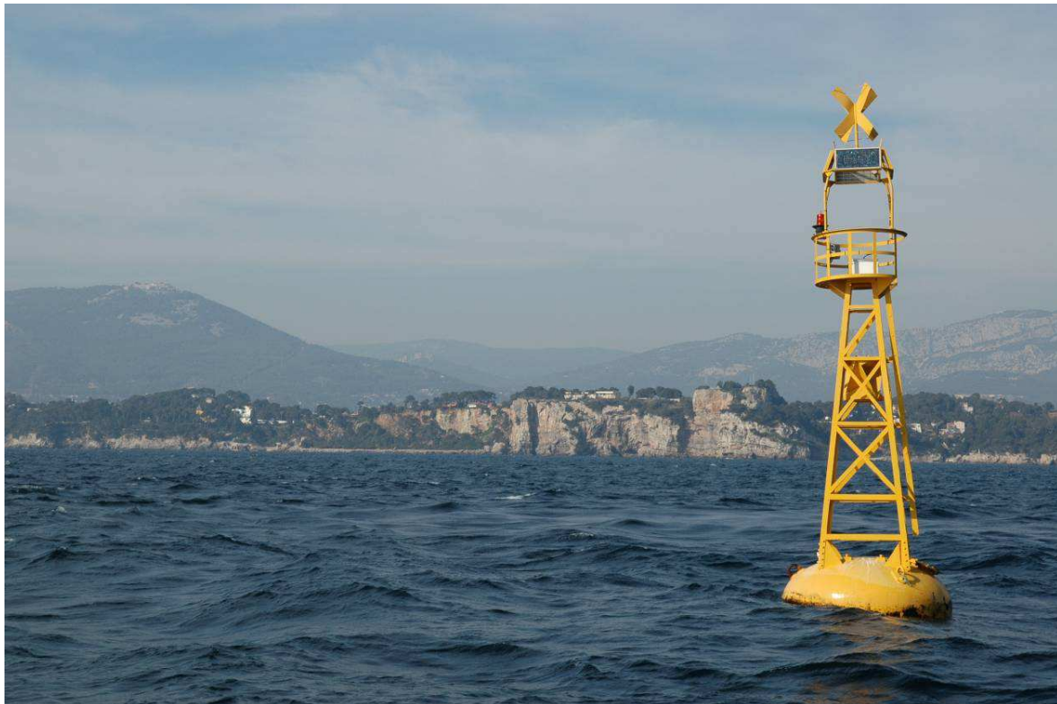
Bouée de signalisation du rejet de la station Amphora
